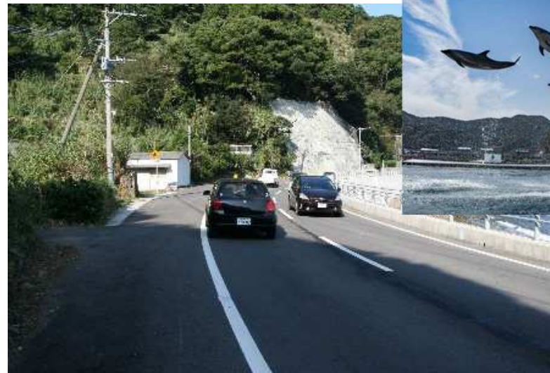
つくみイルカ島までのアクセス道路の整備例 (四浦日代線：津久見市)
