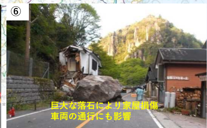
県道森耶馬溪線（中津市耶馬溪町深耶馬）1箇所
