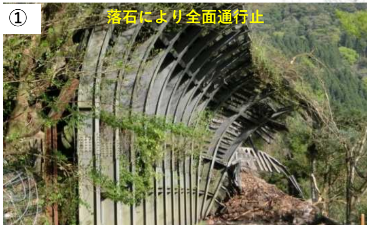
国道212号（日田市大山町西大山）
