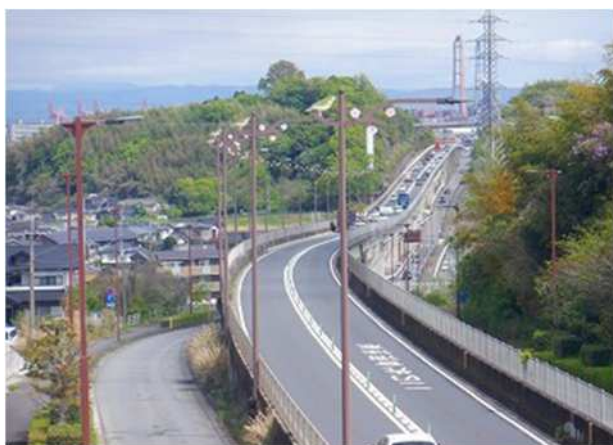
道路照明電気代 約 2.4 万円 / 基・年 (年間約 2 億円) ※県内の照明数 約 8 千基
