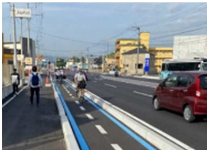
自転車道整備 (国道442号宗方拡幅：大分市)
