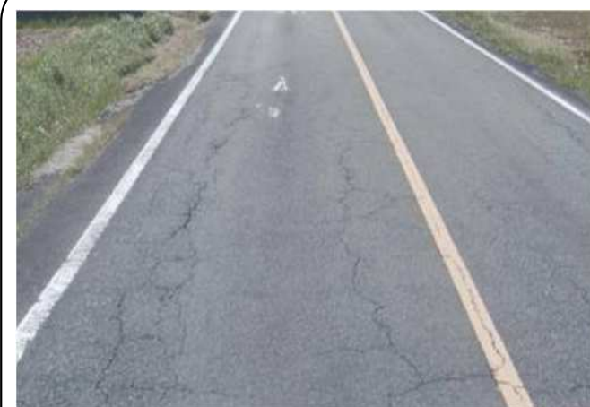
舗装補修 約 1.1 万円 / m 2
